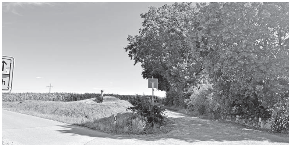
Der historische Verbindungsweg Poppenreuth – Mildach wird zum reinen Grünweg und nur noch für Radfahrer und Fußgänger nutzbar sein. (Foto: ropi)
