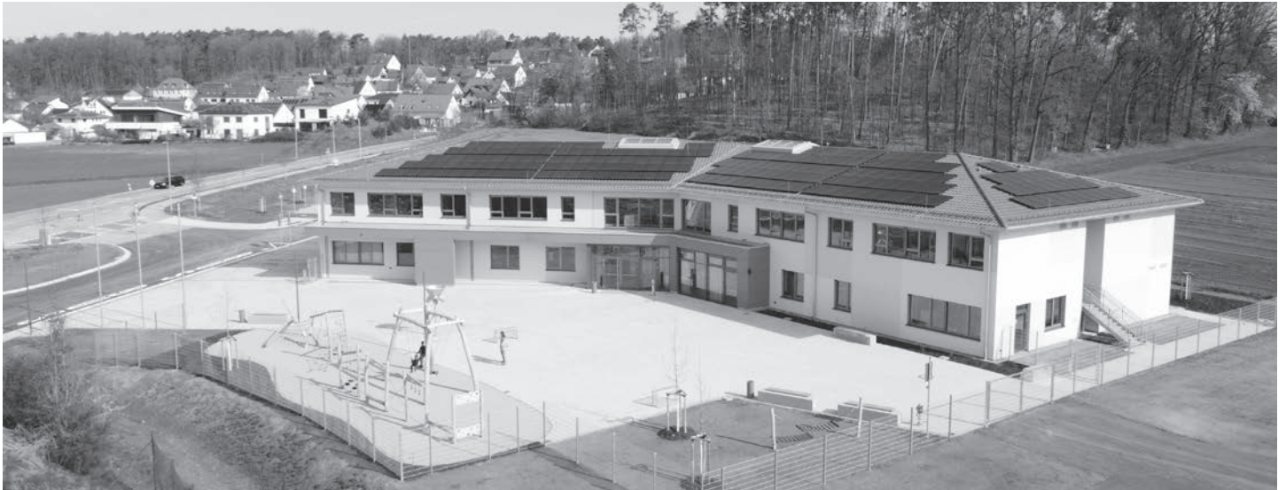
Die neue Grundschule kurz vor der Einweihung.
