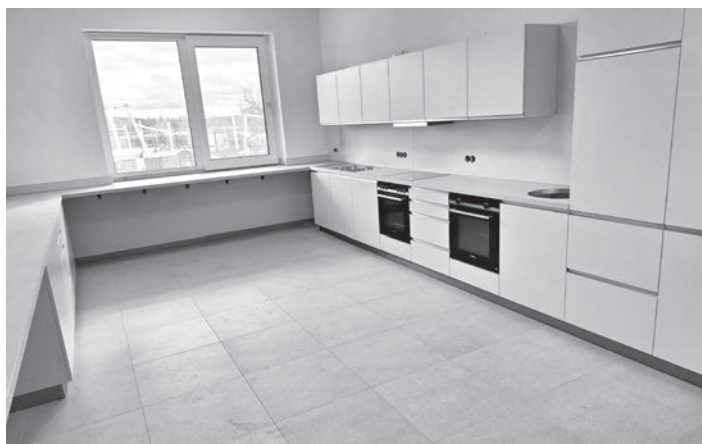
In der Hausmeisterkabine (Bild) neben dem Haupteingang und im Lehrerzimmer sind die hübschen neuen Küchenzeilen fertig eingebaut.
