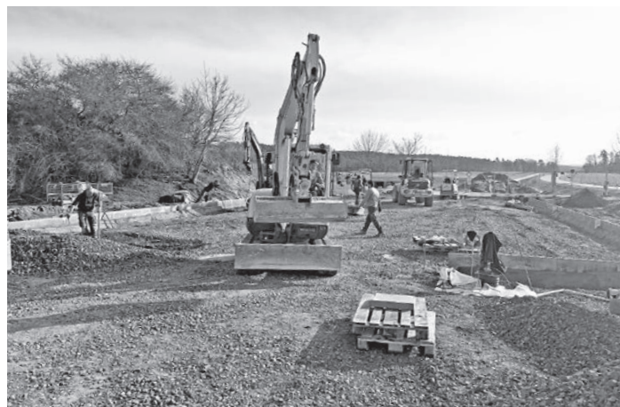
Auf dem südlichen Parkplatz haben nach der langen Winterpause die Arbeiten wieder begonnen. Auch im Außenbereich soll bis Ostern alles fertig sein.
