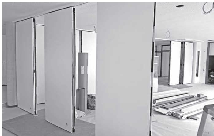
Die mobilen Trennwände in den zentralen Bereichen des EG (Aula/Musiksaal) und OG (Schülerbibliothek/ Offene Lernlandschaft) sind eingebaut.
