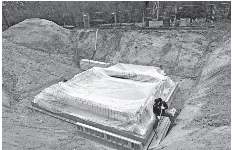
Die Grundplatte des künftigen Pumpwerk-Gebäudes wurde vor Weihnachten fertig betoniert und anschließend mit einer Schutzfolie abgedeckt. Im Frühjahr kommt nun der Rest des Gebäudes dran.
