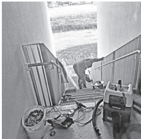
Die beiden eleganten Rettungstreppen vom Obergeschoss ins Freie in der Mitte der Ost- und der Westfassade sind eingebaut.
