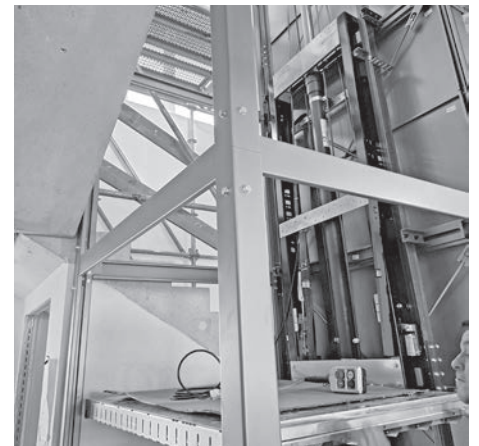
Die Aufzuganlage wird ebenfalls eingebaut. Übrigens wird er nicht emporgezogen, sondern von einer Hydraulik gedrückt.
