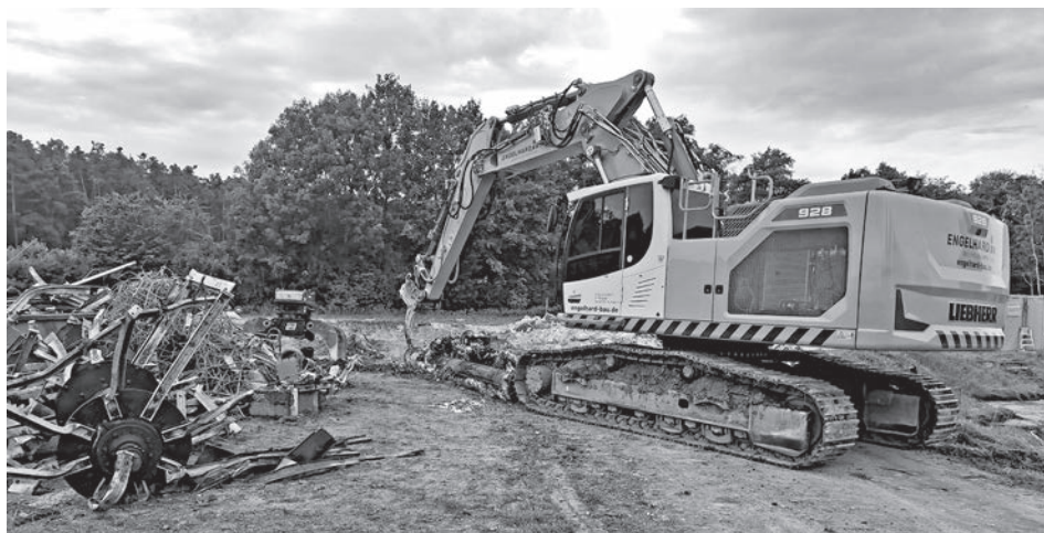
Schmerzliche Notwendigkeit: Die Umbauten der Kläranlagen Haag und Poppenreuth müssen gesetzlich komplett von den Anschlussnehmern der Abwasseranlage Kammerstein finanziert werden. Im Bild der Stand der Umbauarbeiten in Haag etwa Ende September.
