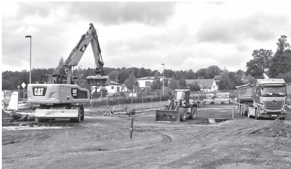
Die Firma Biedenbacher packt die Arbeiten im Außenbereich sehr energisch an. Hier beseitigt ein Bagger die Asphaltdecke der bisherigen Einfahrt ins Gelände. Rechts, wo der Radlader und der Lastwagen stehen, sieht man schon den künftigen Lehrerparkplatz. Dieser ist bereits egalisiert und roh asphaltiert. (Foto: Wolfram Göll)
