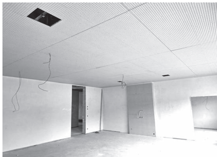
Schon einigermaßen wohnlich schauen diejenigen Räume aus, in denen die Trockenbauer mittlerweile die Akustikdecken angebracht haben. Man kann sich hier jetzt ganz normal unterhalten, die Decken hallen nicht mehr. Anfang Oktober betraf das neun Räume im Erdgeschoss, unter anderem den Werkraum (Foto). (Foto: Wolfram Göll)
