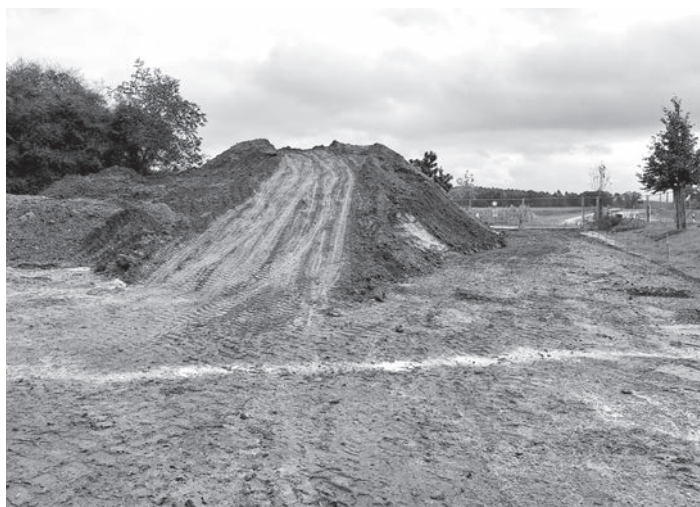
Der südliche Parkplatz wurde von der Firma Biedenbacher zu allererst eingeebnet und roh asphaltiert. So wurde Platz für den Aushub geschaffen, der bei der Egalisierung des gesamten Geländes anfallen sollte. Noch weiter südlich davon liegt die Behelfs-Zufahrt zum Gelände des SV Kammerstein. (Foto: Wolfram Göll)
