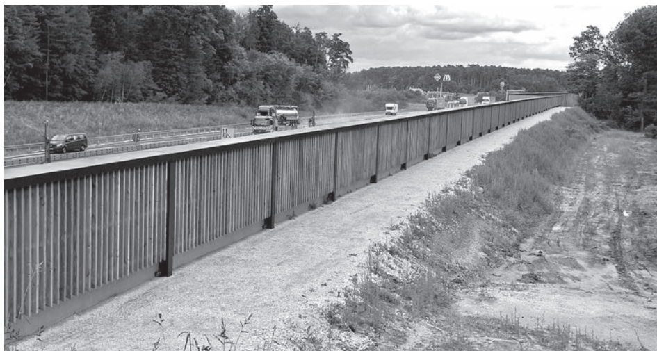
Die Lärmschutzwand im Bereich der Ausfahrt Schwabach-West in Richtung Haag wurde im September und Oktober gebaut. (Foto: Wolfram Göll)
