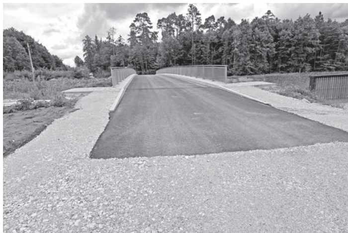
Die Feldwegbrücken über die Autobahn sind jetzt wieder benutzbar. Hier die Brücke zwischen Haag und dem Waldgebiet Laubenhaid. (Foto: Wolfram Göll)
