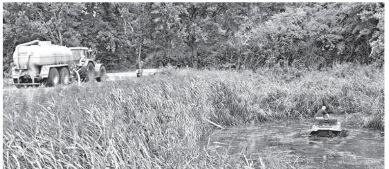
Abtransport des letzten Klärschlammes aus der Kläranlage Haag. Dabei wird auch ein Amphibienfahrzeug zum Aufwirbeln des Klärschlammes benutzt. Das Nachklärbecken (Bild) wird verfüllt, das links, daneben liegende Vorklärbecken wird künftig als Regenrückhaltebecken fungieren.
