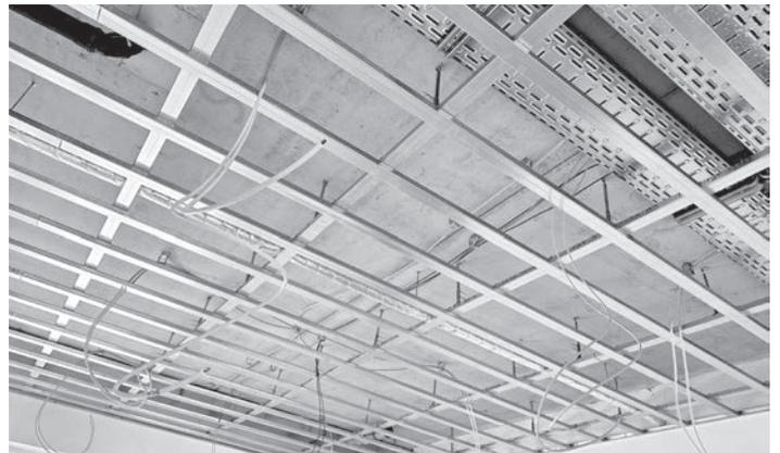
*Die Unterkonstruktionen des Trockenbaus für die abgehängten und Akustik-Decken sind in den meisten Räumen bereits angebracht.*
