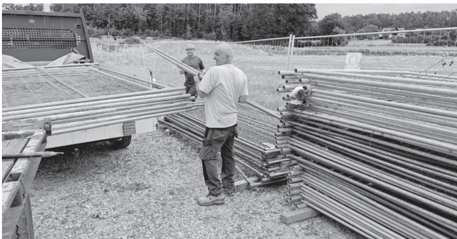
Der Beginn der Bauarbeiten für die neue Grundschule ist eher unspektakulär: Zunächst wurde der Bauzaun aufgestellt und das Baufeld damit abgeriegelt.
