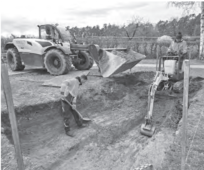
In der Woche nach Ostern haben die Arbeiten auf dem Friedhof Barthelmesaurach begonnen.
