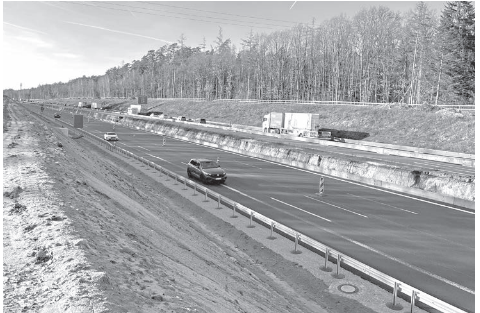
Derzeit beginnt der zweite Bauabschnitt des sechsstreifigen Ausbaus der A6. Der Verkehr läuft dann über die südliche Fahrbahn. Die Arbeiten sollen Ende 2024 vollendet sein.
