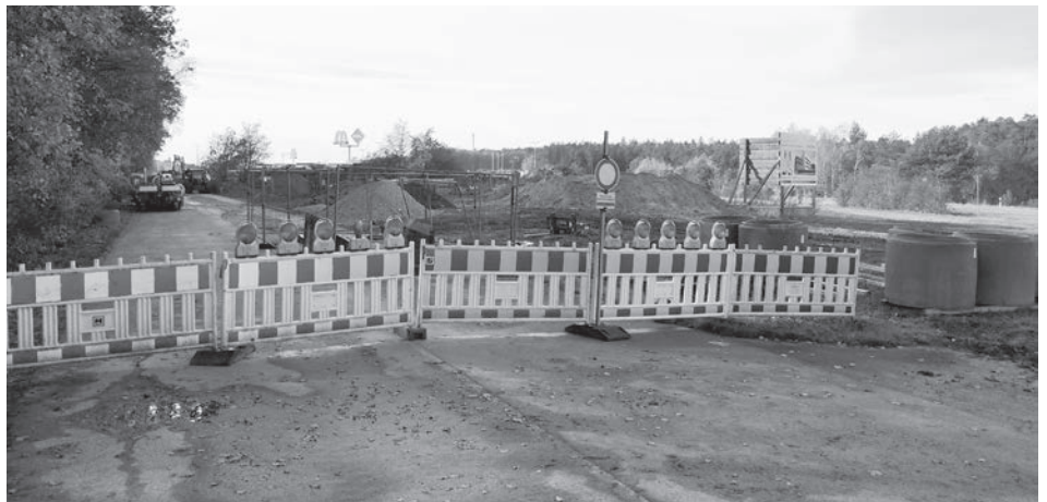
Auf der Kammersteiner Seite des Autohofs wird bereits seit Oktober gebaut. Die bisherige Absperrung steht genau auf der Stadt-/Gemeindegrenze. (Foto: Wolfram Göll)
