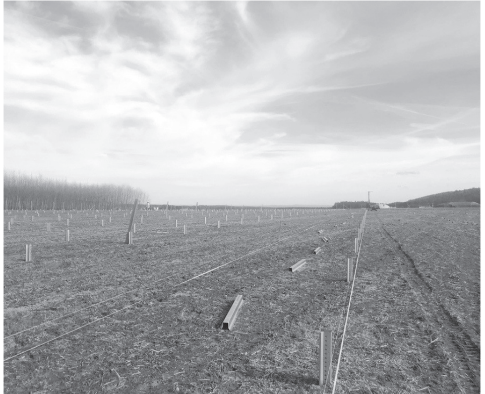
Baywa r.e. / wog Die Baustelle des Solarparks in Kammerstein nimmt langsam Formen an. (Foto: BayWa r.e.)
