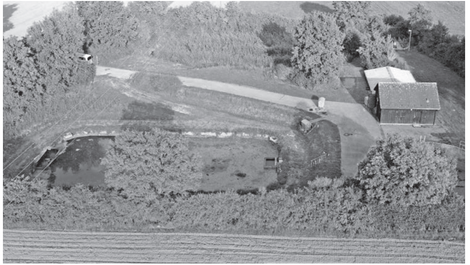
Die Kläranlage in Haag gilt schon seit Jahren als überlastet. Sie soll durch ein Pumpwerk ersetzt werden, das Schmutzwasser fließt dann in die Kläranlage nach Schwabach. (Foto: ropi)
