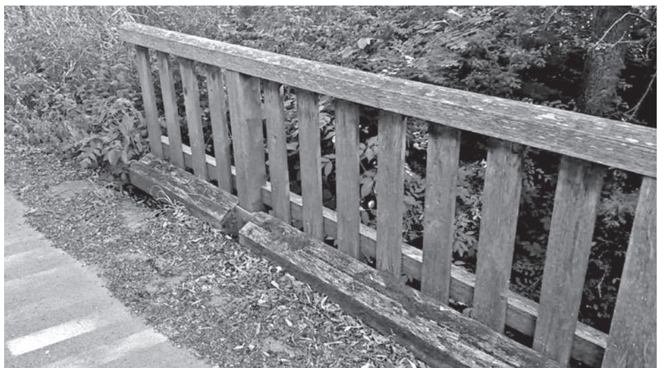
Das Brückengeländer wird erneuert.
