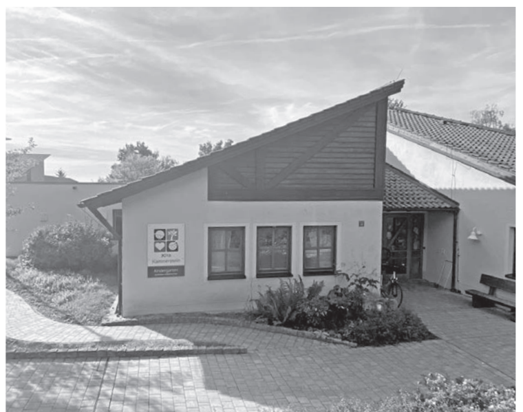
Die Kita Kammerstein wurde das Ziel von Einbrechern.
