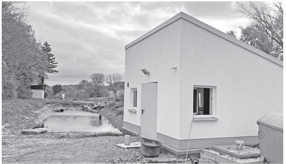
*Das neue Pumpwerk in Barthelmesaurach ist jetzt endgültig in Betrieb. Das Abwasser wird von hier über den Aurachtsammler zur Kläranlage Roth gepumpt. Im Moment laufen noch Außenarbeiten. (Foto: ropi)*
