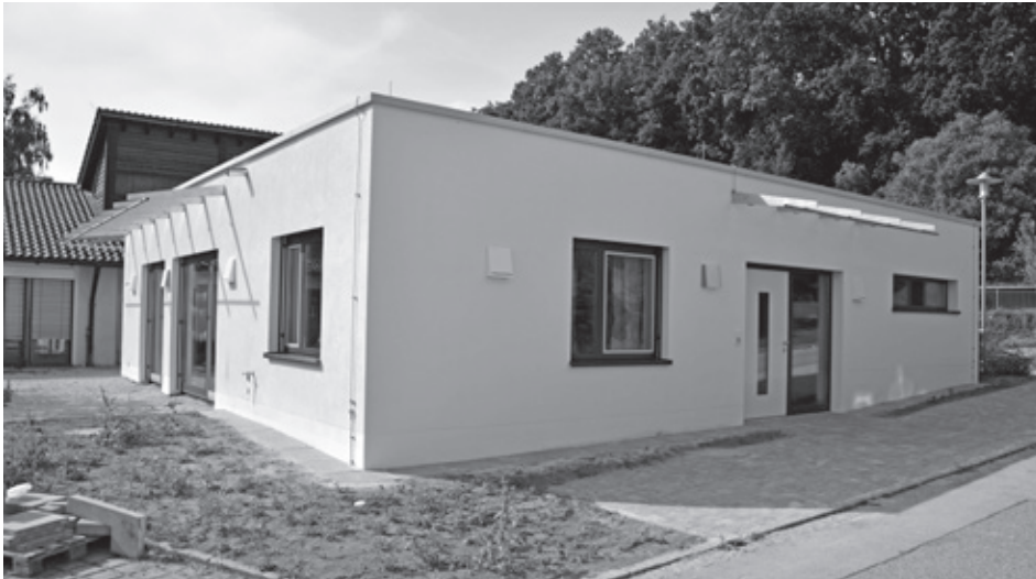
Der neue Erweiterungsbau der KiTa ist bis auf den Außenbereich fast fertig.
